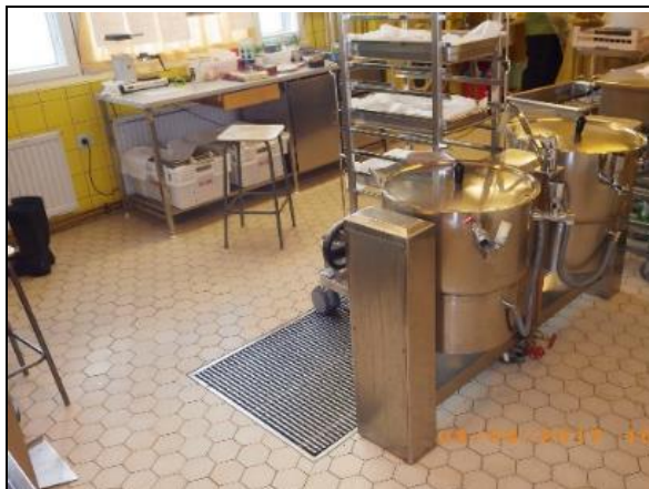
Koulun ruokalan keittiön laitteistoa.
