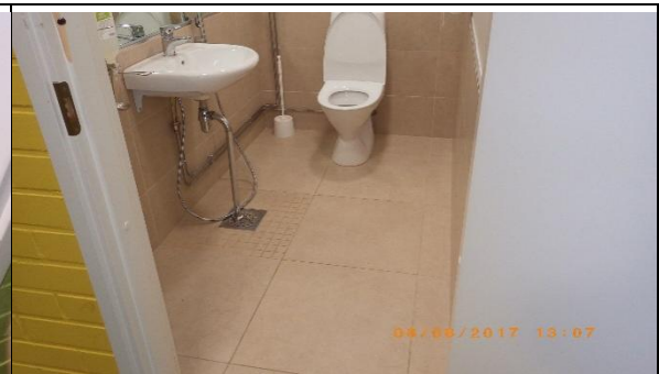
C osan WC tilat on remontoitu 2014
