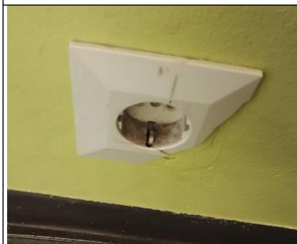
Rikkinäinen pistorasian kansi.
