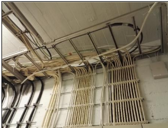
Sähköpääkeskushuoneen tikashyllyt
