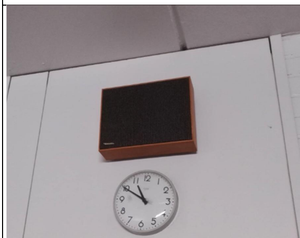
Alkuperäinen luokkahuoneen keskusradion kaiutin.
