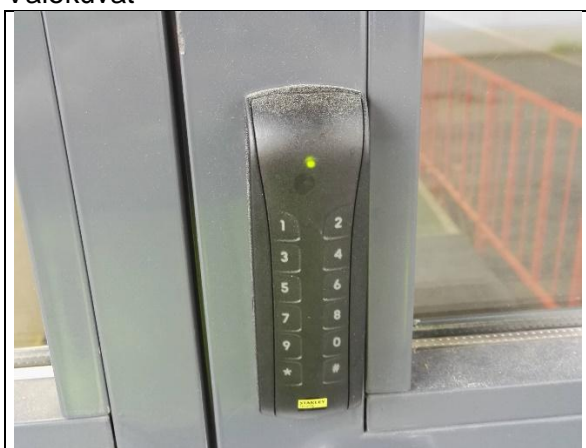
Kulunvalvontajärjestelmän koodinäppäimistö
