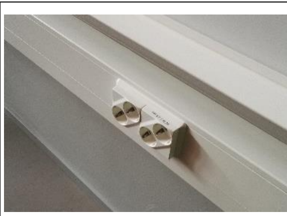
Luokkahuoneen johtokanava
