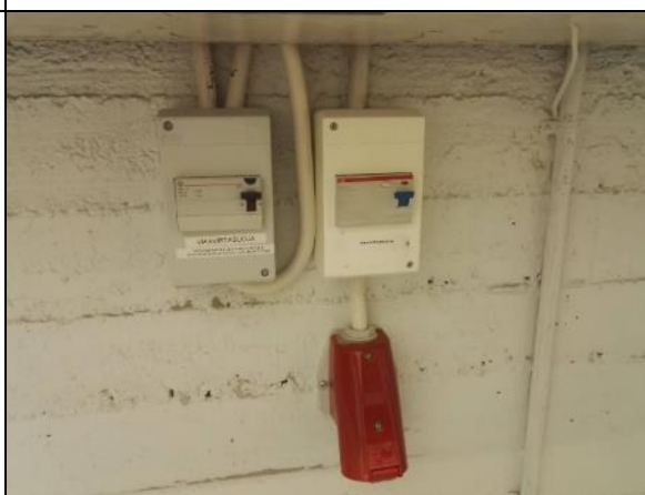
Voimapistorasia vikavirtasuojauksella.
