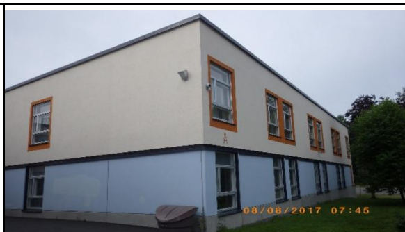
Julkisivurakenne, alaosassa siniseksi maalatut kuorielementit ja vaaleassa yläosassa on lämpö- rappaus.
