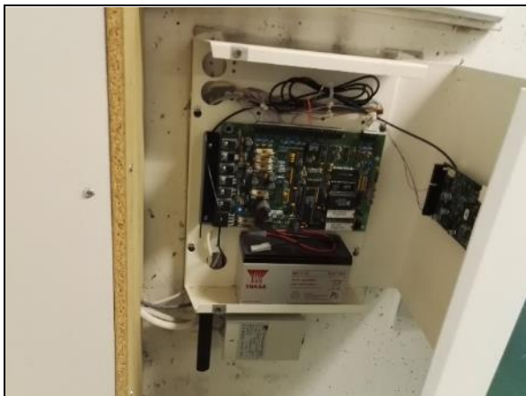
Ovilukitusjärjestelmän pääyksikkö.
