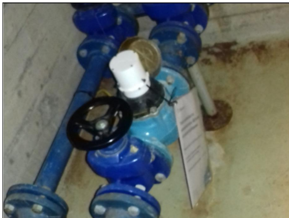
Kiinteistön vesimittari
