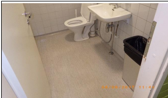
A osan WC tilat on remontoitu 2013
