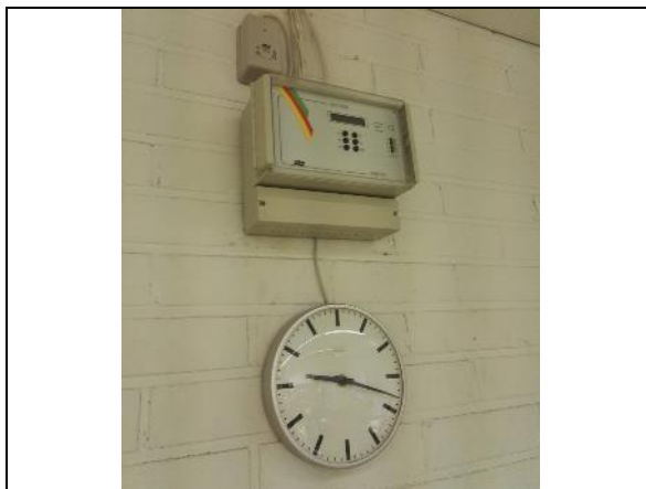
Ajannäyttöjärjestelmän keskusyksikkö ja pääkello.
