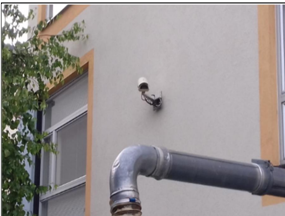
Julkisivuun asennettu valvontakamera
