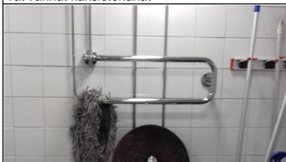
Siivouskomeron kiertovesipatteri
