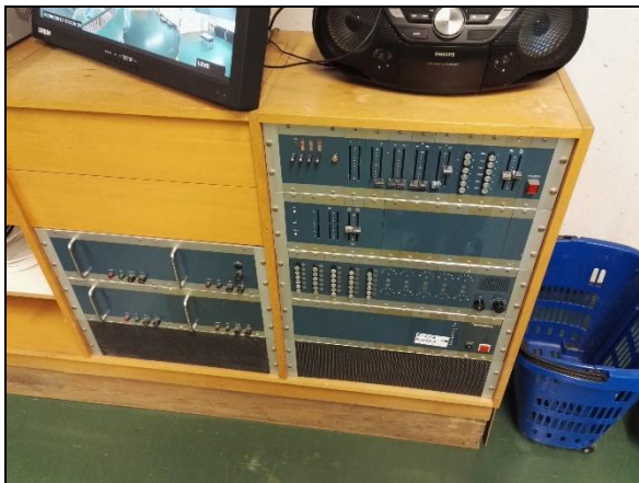
Alkuperäinen keskusradion ohjausyksikkö
