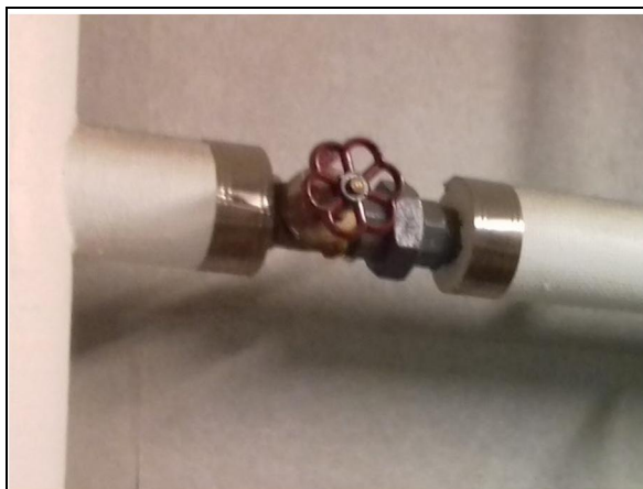
Vanha messinkinen karaventtiili B-rakennuksen IV-konehuoneessa
