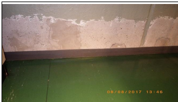
Rakennusosan C luokassa 16 on hiottu seinien alaosa
